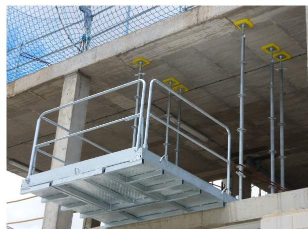
Plataforma instalada con puntales no incluidos
